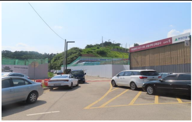
송수-1구간 종점부 전경
