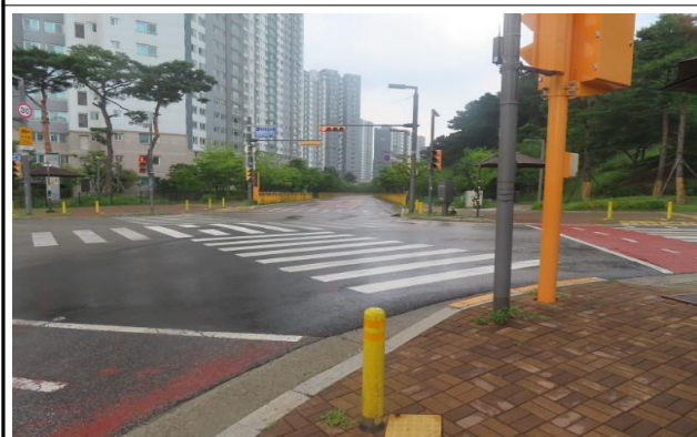
송수-3구간 시점부 전경
