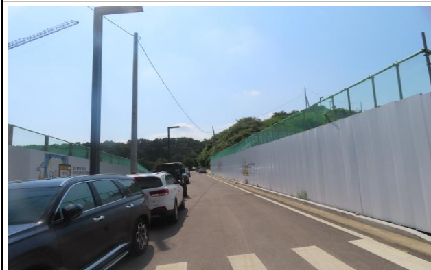
송수-2구간 시점부 전경
