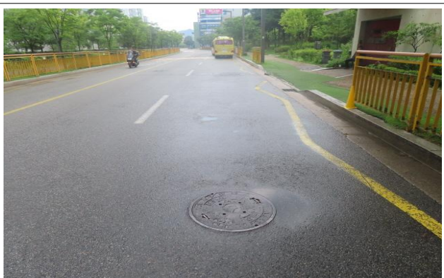
송수-3구간 종점부 전경
