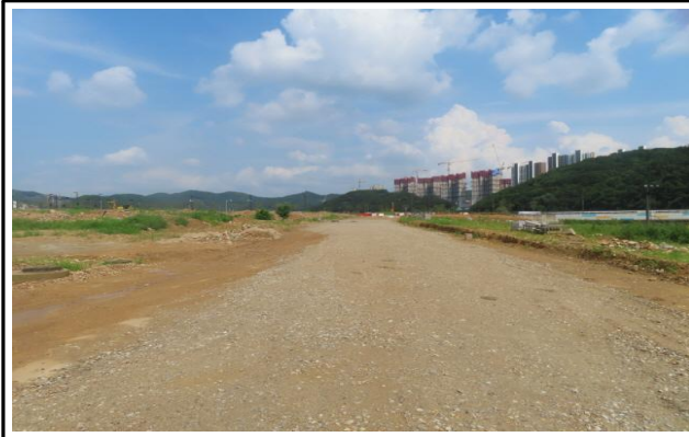
송수-1구간 시점부 전경
