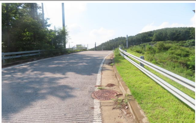
송수-2구간 종점부 전경
